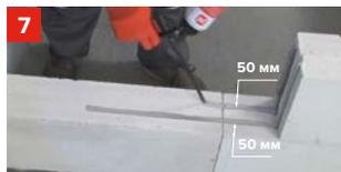
Нанести клей-пену параллельными полосами шириной 20–30 мм на горизонтальные и вертикальные грани блока. При нанесении клей-пены сделать отступ в 50 мм от края блока.
