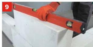
В течение 3-х минут после выпуска клей-пены произвести укладку блока и его корректировку при помощи киянки и уровня.
